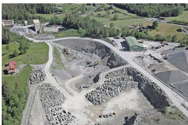
Hier wurde der Schotter verarbeitet: In der Bildmitte ist die Siebanlage auf dem Steinbruchgelände ersichtlich. Foto: PD
