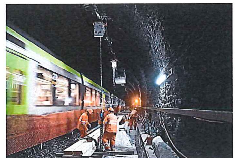
Seit Mitte 2018 wird der Tunnel zwischen Kandersteg und Goppenstein erneuert. Foto: BLS
