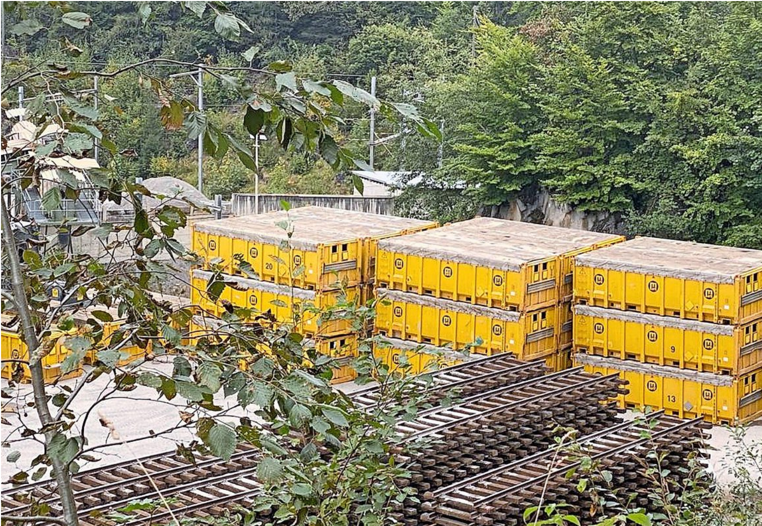
Im Steinbruch stapelten sich in den letzten Tagen die mit Altschotter gefüllten Container und die Gleisjoche. Foto: zvg
