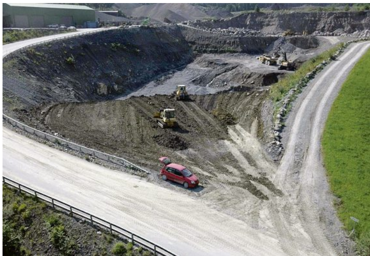
Die Kiesgrube Mitholz wurde in den letzten Wochen mit einer meterhohen Schicht Erde aufgefüllt. Foto: zvg
