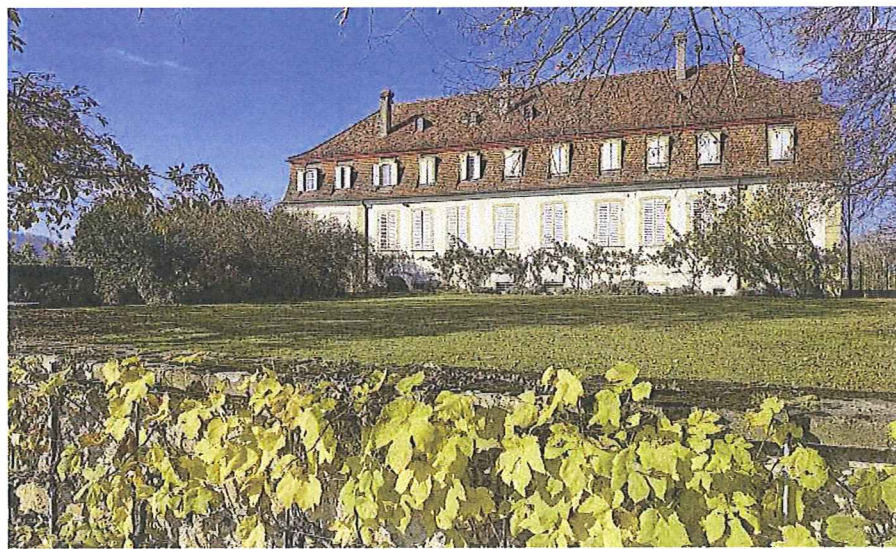
Der Kanton zieht sich vom Schloss Mur zurück. Der Staatswein wird zukünftig von der Burgergemeinde Murten in Mötier hergestellt.
